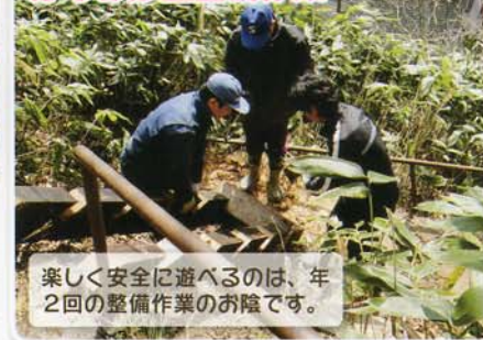
ほなみが丘整備作業
